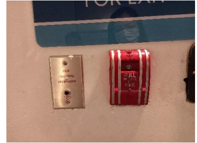
Fireman Phone Jack และ Fire Alarm Manual Station
